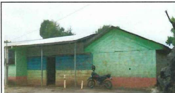
Foto 3: Rehabilitación de muro por aula.
