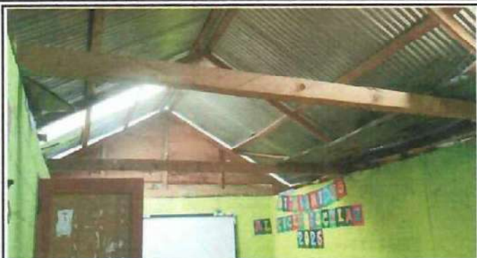
Foto 1: Estructura de techo.
