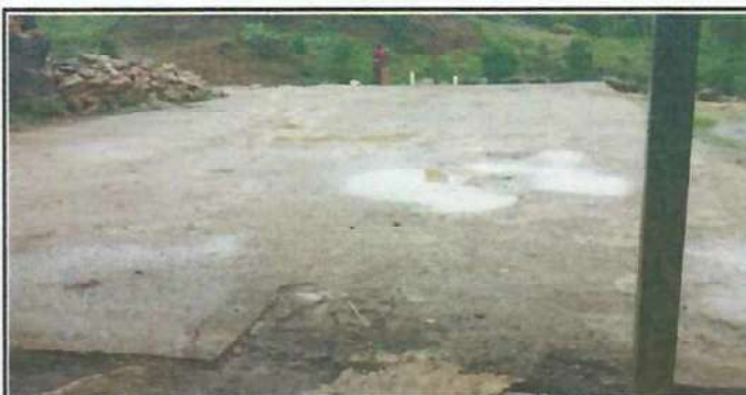
Foto 6: Losa de patio
